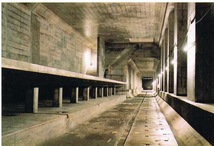
トンネル工事が完成した舞岡駅
